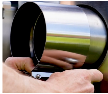
Abbildung 14: Befestigung der Befestigungsschelle am Stutzen des Ofens
