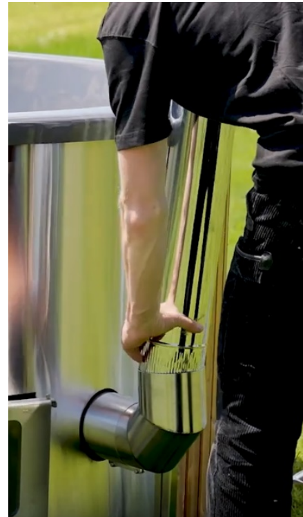
Abbildung 15: Montage des unteren Rohres
