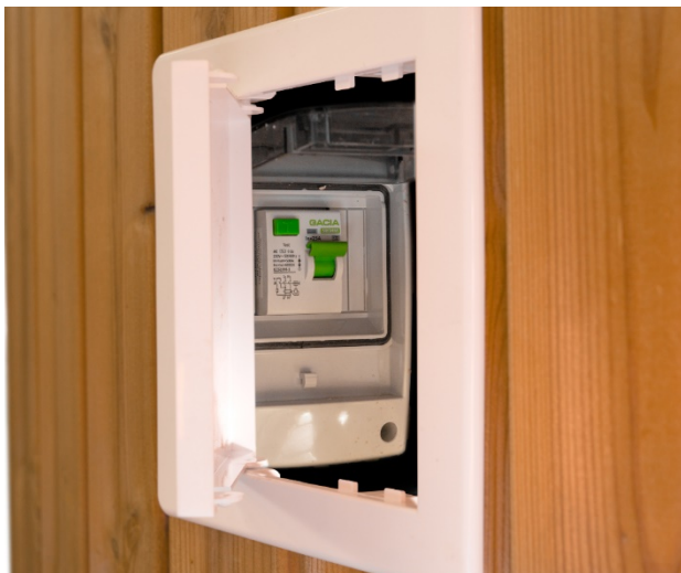
Abbildung 22: Position und Darstellung des FI (eingeschaltet)
