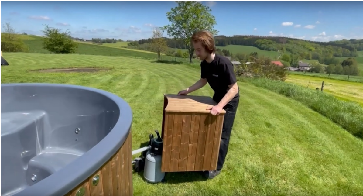
Abbildung 20: Verkleiden der Sandfilteranlage
